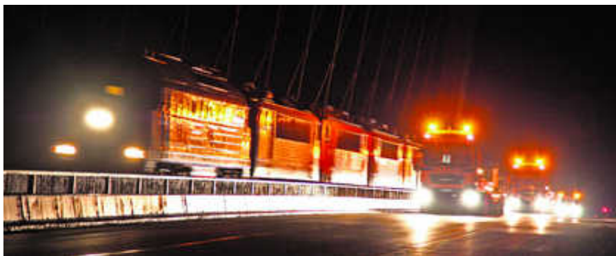
Kraftakt bei Windstärke 11: Gigantische Last durch Lokomotiven und mit Blei beladene Lkw wirkt auf die Fehmarnsundbrücke ein. Noch bis Montag sammelt die Deutsche Bahn nachts Daten. Fotos zum Weiterklicken: Daniela Nyfeler
